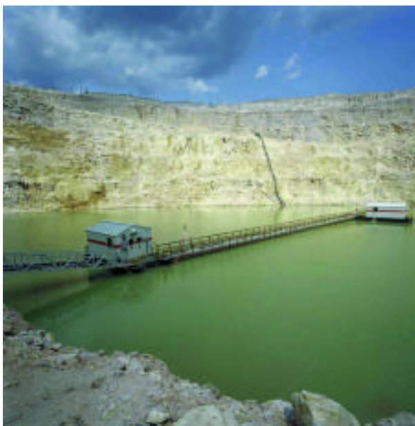
Photo 3 - Site de stockage des résidus de traitement sous tranche d'eau ; site JEB à McClean, Saskatchewan, Canada
