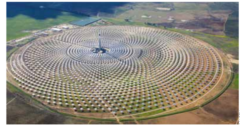
FIGURE 4 Centrale solaire à concentration Noor III située à Ouarzazate au Maroc.
